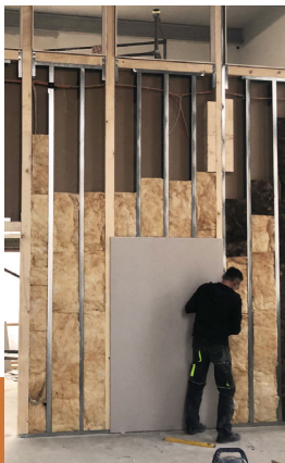
Trocken- und Innenausbau
